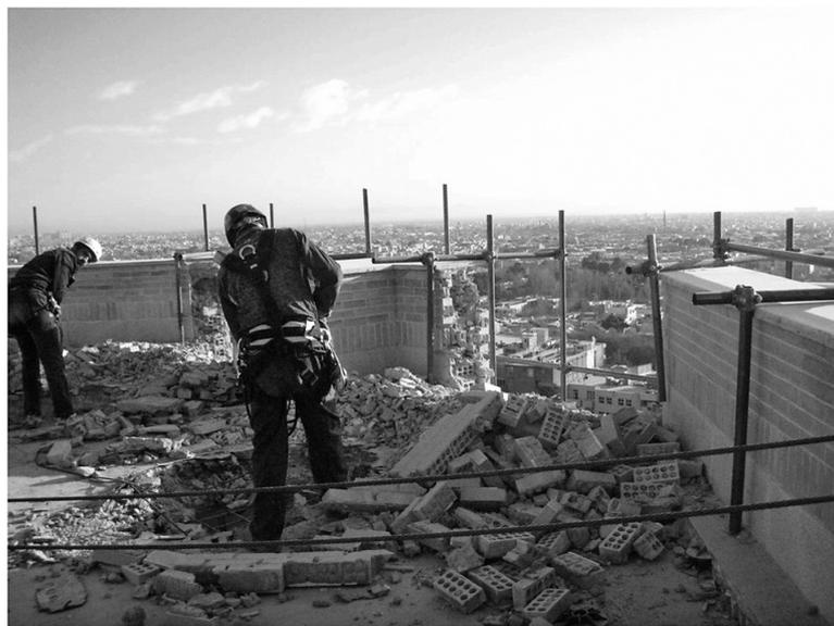
写真5 ヤハン・ナーマ商業施設の取壊し作業
