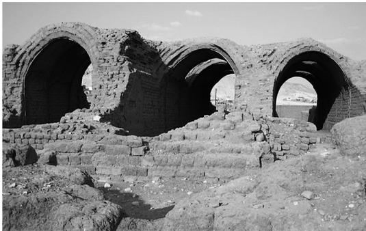
写真4 ラメセス2世葬祭殿（ラメセウム）に残る日干し煉瓦のヴォールト
